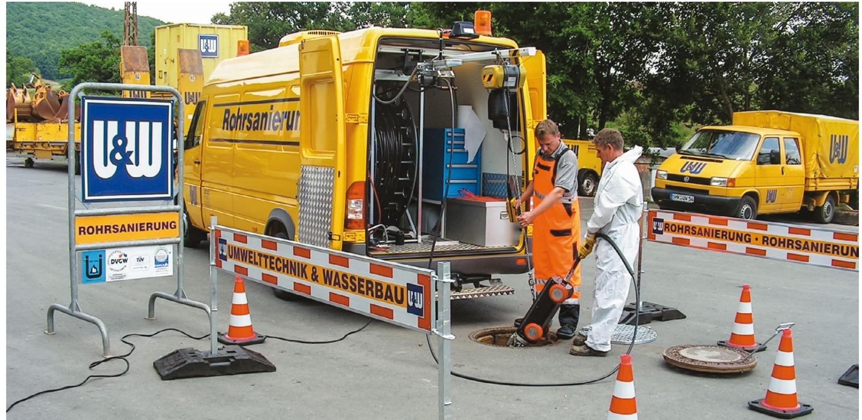
Rohrsanierungstechnik mit Spachtel- und Fräsrobotern DN 150-600
