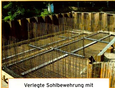
Verlegte Sohlbewehrung mit Stahlwasserbauteilen aus Edelstahl
