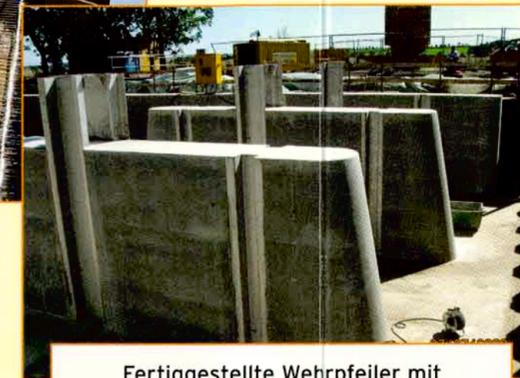
Fertiggestellte Wehrpfeiler mit Stahlwasserbauteilen aus Edelstahl
