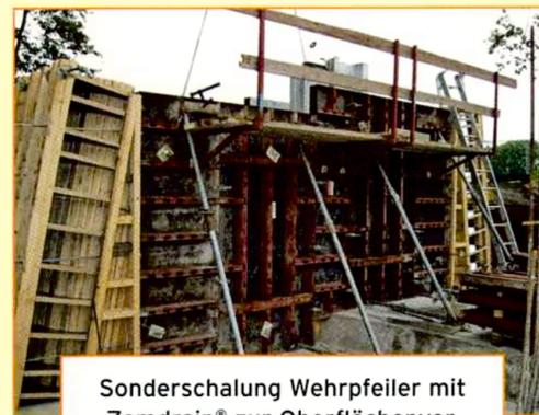
Sonderschalung Wehrpfeiler mit Zemdrain® zur Oberflächenverbesserung des Betonkörpers belegt
