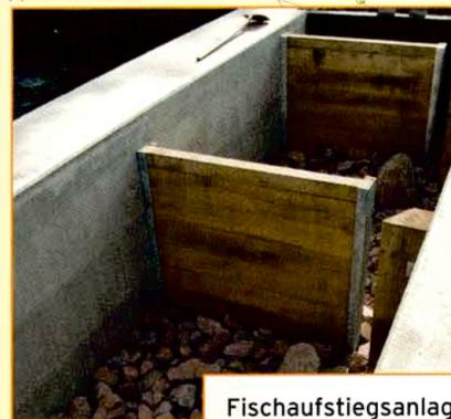
Fischaufstiegsanlage als Vertical-Slot-Pass mit Umlenkblöcken und Trennwänden
