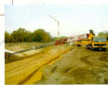
Bauwerk 1 Mündungsbereich Profilsicherung mit Spundwand: Befestigung auf 50 m Länge, Böschungsfußsicherung in der Mulde durch berollten Graben, WBS Kl. IV und V
