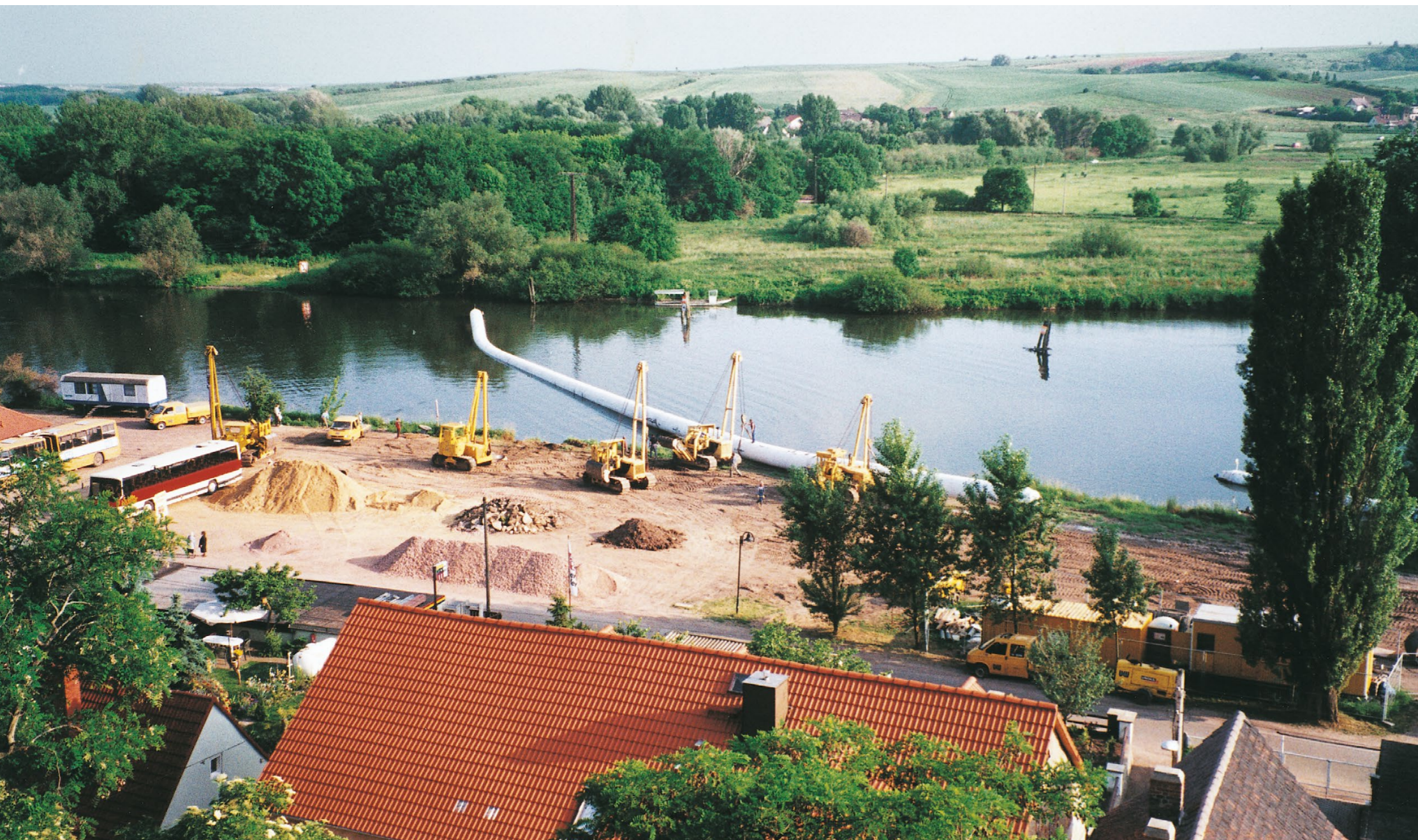
Saale-Düker bei Halle 2 Trapezformdüker Stahlrohr DN 1400, 115 m lang, mit eingezogenen Medienrohren aus PE-HD
