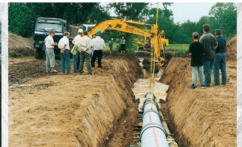
Düker Weiße Elster aus Gussrohr DN 400
