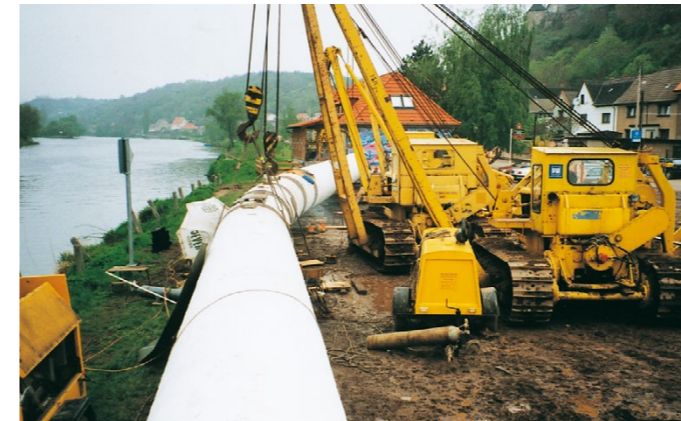
Vorfertigung Saale-Düker bei Halle
