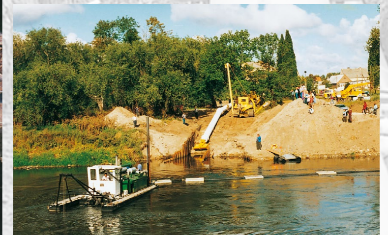
Saale-Düker bei Nienburg aus Stahlrohr DN 800
