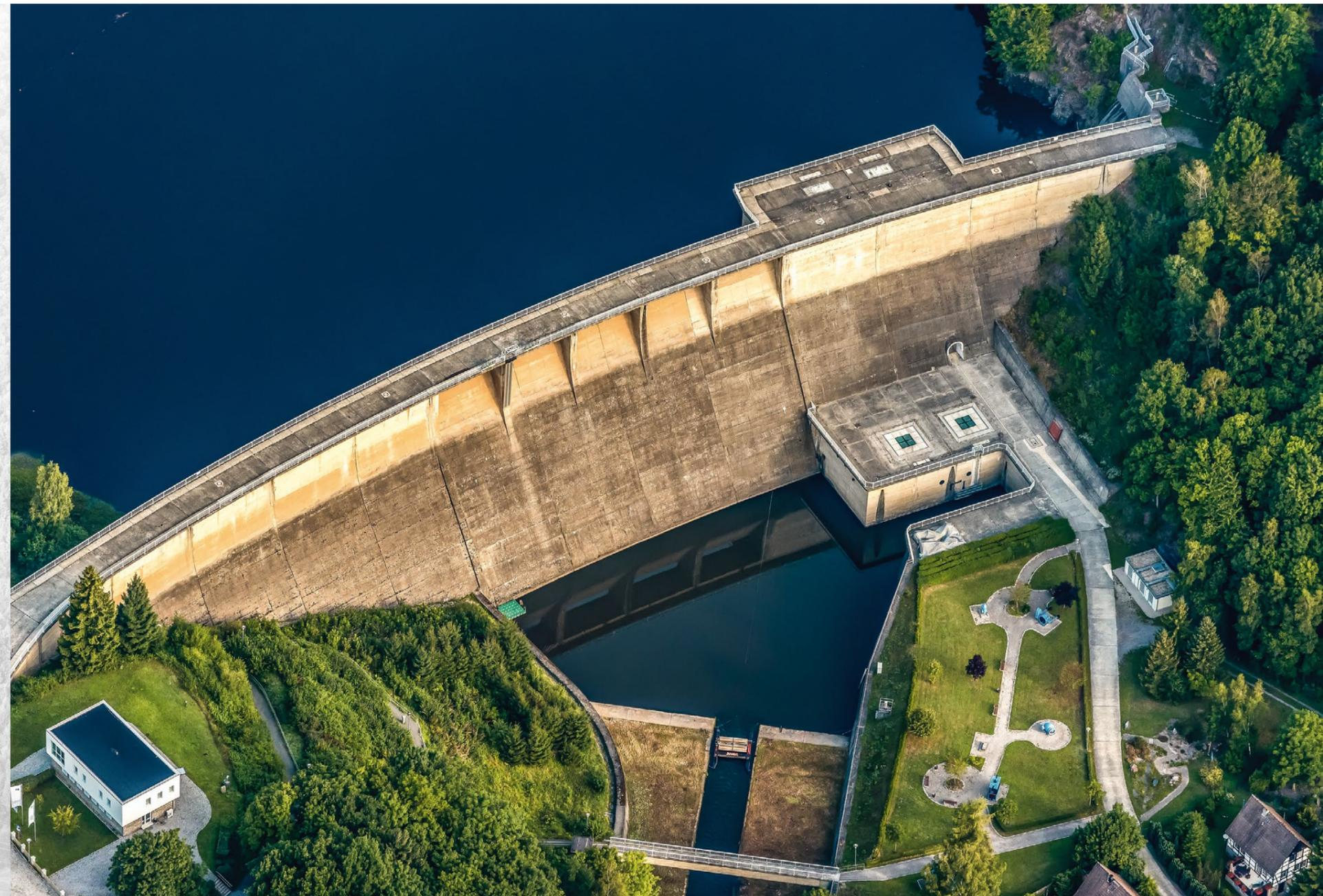
Talsperre Wendefurth mit einer Staumauerhöhe von 43,5 m und einer Kronenlänge von 230,0 m
