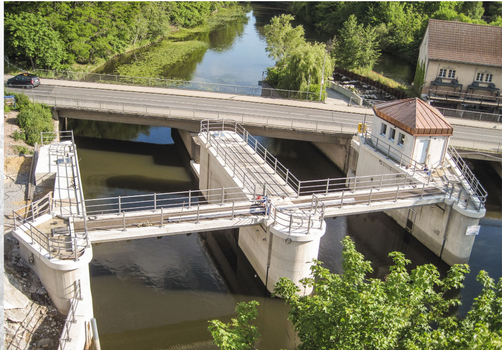
Ersatzneubau des Eisenbütteler Walzenwehres in Braunschweig
