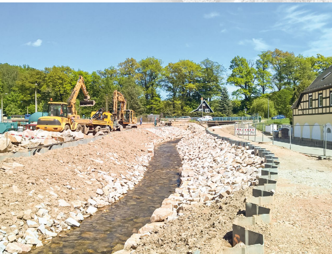
Hochwasserschutz Aubach Greiz
