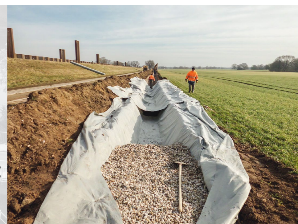
Instandsetzung linker Muldedeich von Lößnitz bis Bad Dübén
