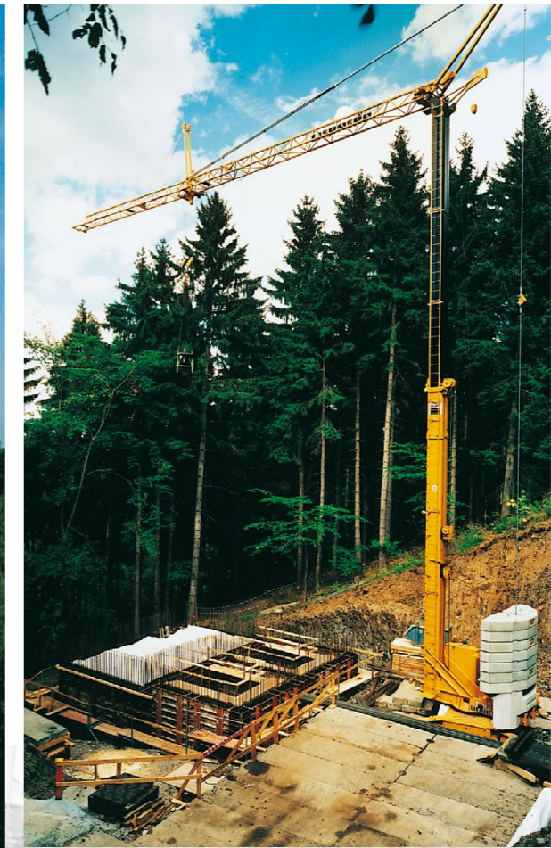
Wasserhochbehälter Wendefurth 2 x 100 m 3
