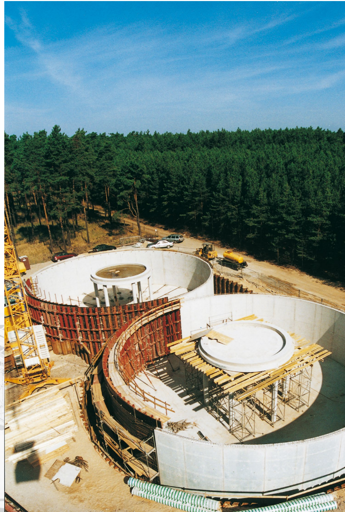
Abb. rechts: Wasserhochbehälter Kreuzberge 2 x 2.000 m 3 (Fernwasserleitung Lindau – Lutherstadt Wittenberg)
