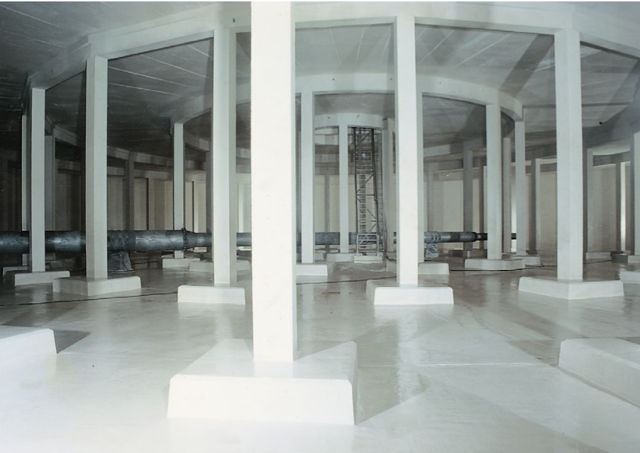
Wasserhochbehältergruppe Wienrode Innenansicht, 2 x 12.500 m 3
